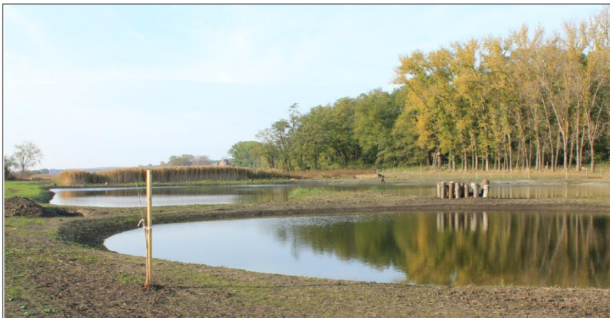
Obrázek 75 Lokalita těsně po realizaci opatření (Zdroj: Ing. Dr. Marada)
