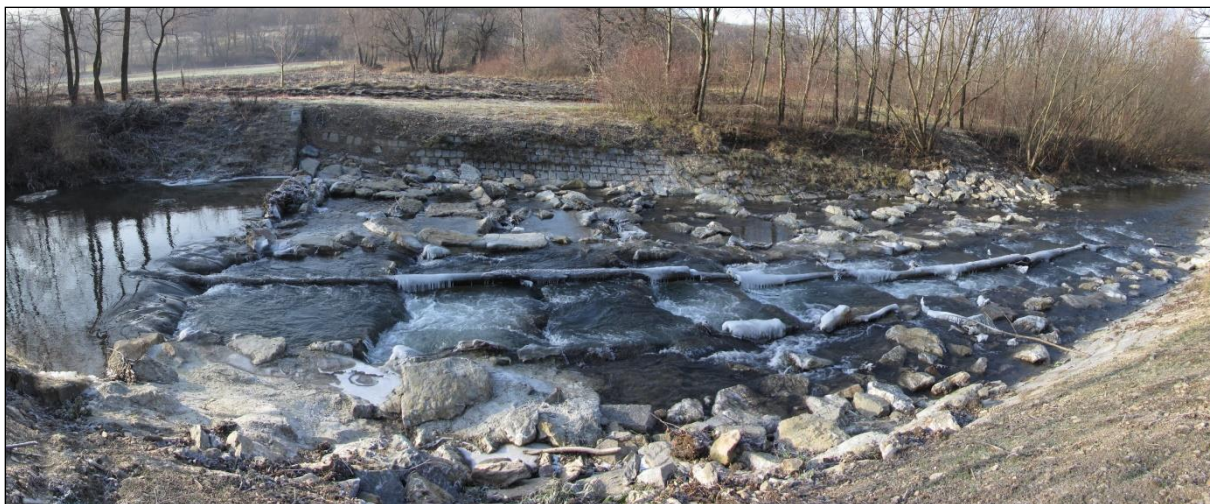
Obrázek 78 Vybudování balvanitého skluzu, 2009 (zdroj: D. Veselý, Povodí Moravy, s.p.)
