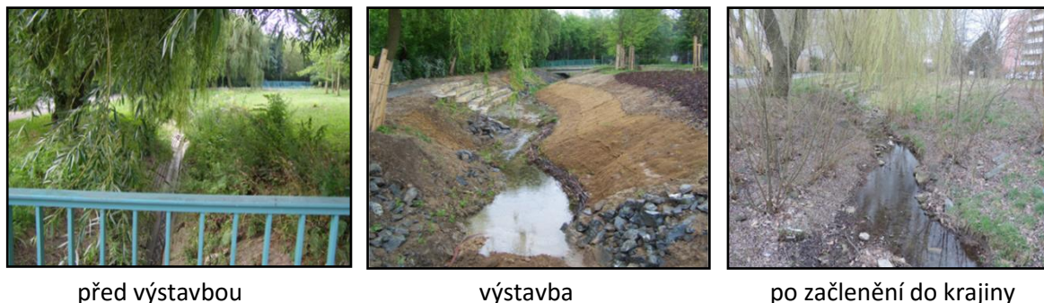
Obrázek 42 Soubor fotografií zachycujících způsoby stabilizace koryt v intravilánech a jejich blízkosti
