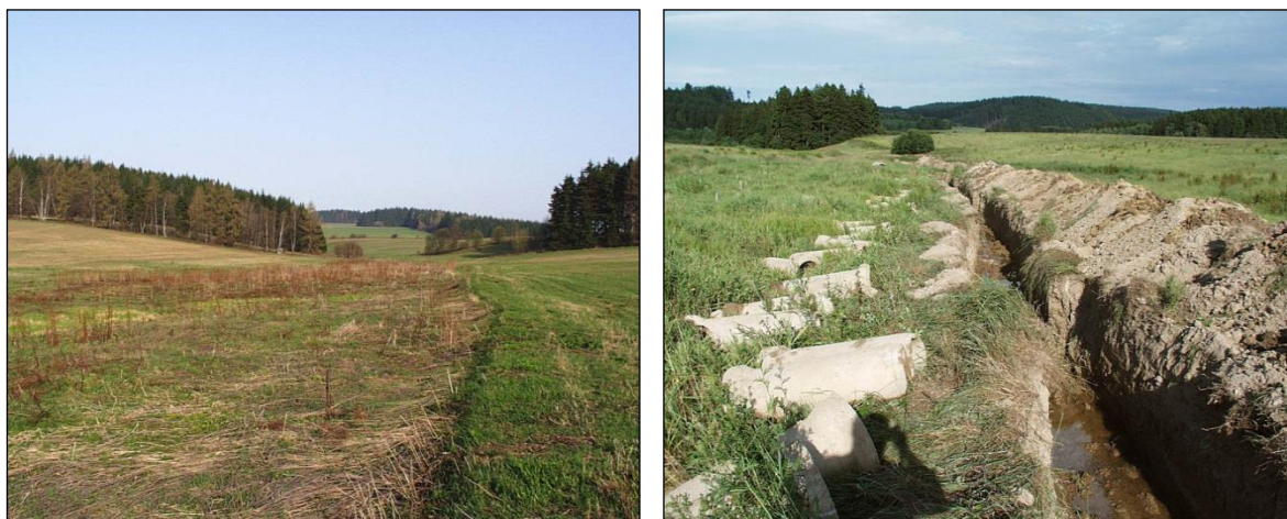
Obrázek 86 Pohled na pás pozemku s jedním ze zatrubněných toků před revitalizací a pohled na likvidaci trubního vedení v roce 2000
