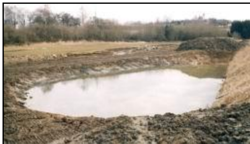
Obrázek 52 Jedna z postranních tůň revitalizační akce na potoce Brodec u obce Načeradec těsně po dokončení. Byla hloubena jako mělká mísa s mírně sklonitými břehy (období 2002-2003).
