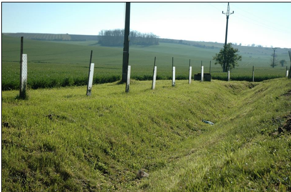
Obrázek 14 Ukázka zatravněného příkopu (zdroj: VÚV TGM, v.v.i.)
