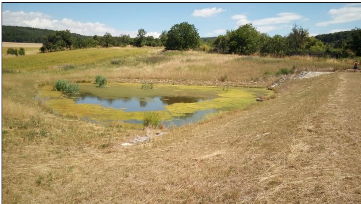
Obrázek 28 Ochranná nádrž s malým zásobním prostorem v k. ú. Staré Hvězdlice (zdroj: VÚV TGM, v.v.i.)
