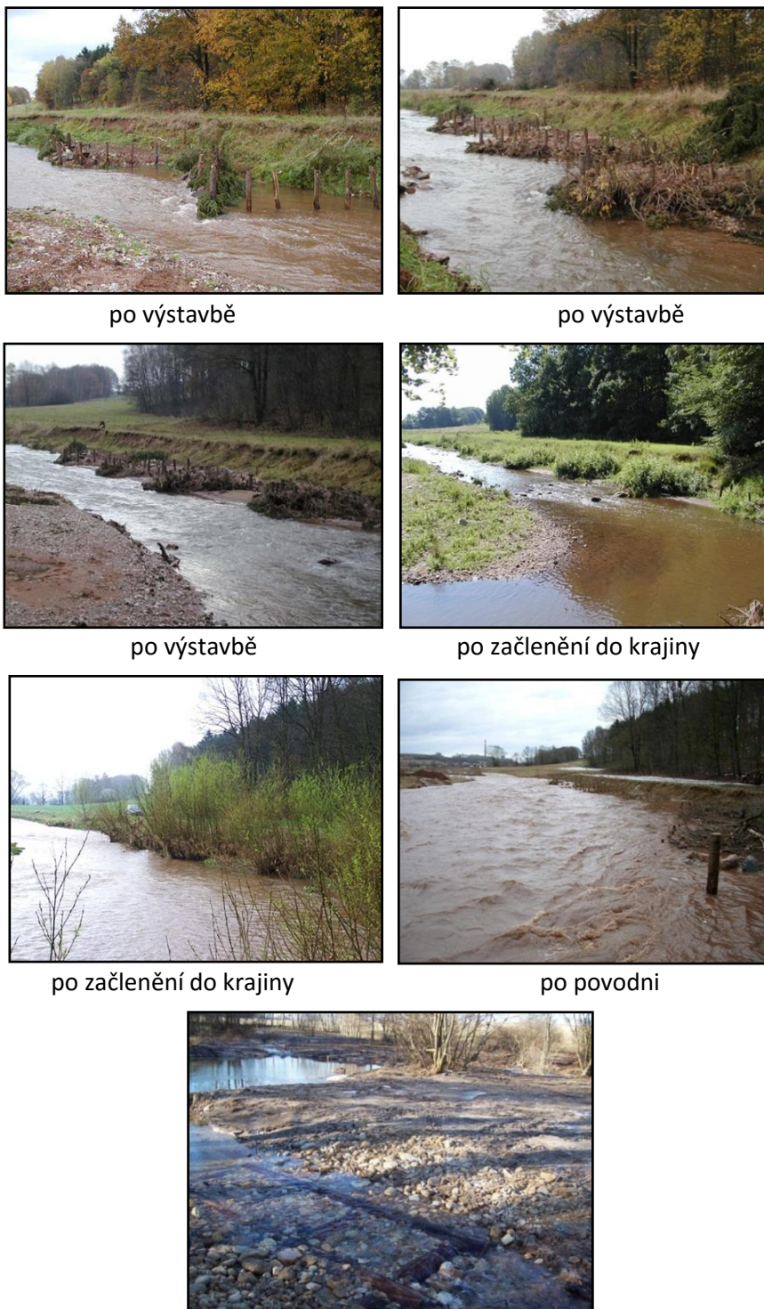
Obrázek 39 Skupina fotografi zachycujících využití mrtvého dřeva při stabilizaci toků
