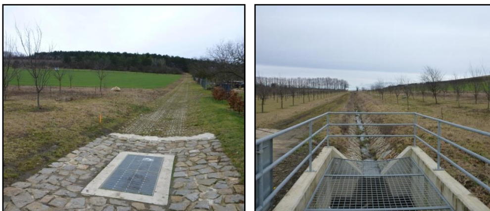
Obrázek 58 Zpevněný průleh slouží i jako vedlejší polní cesta, ukončen lapačem splavenin a sedimentační jímka, zpevněný příkop a zachycovací zatravněné ovocné sady (Zdroj: EKOTOXA s. r. o.)
