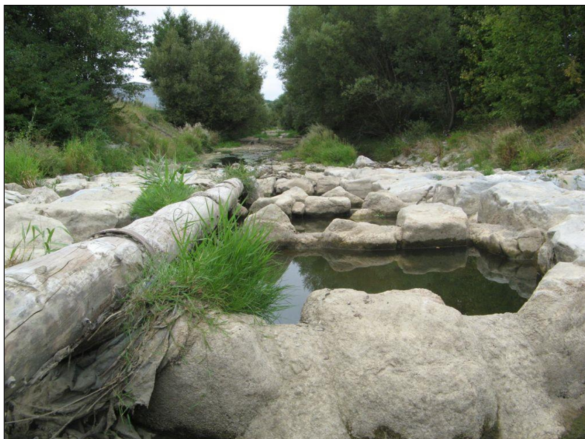
Obrázek 79 Tůňě rybího přechodu při nulovém průtoku v roce 2012 (zdroj: D. Veselý, Povodí Moravy, s.p.)
