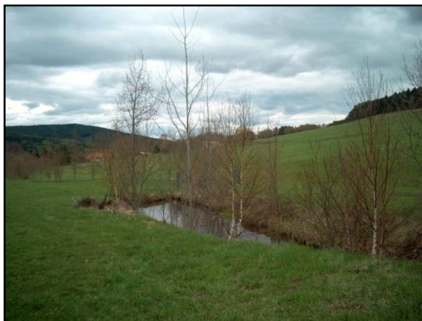
Obrázek 50 Hlubší tůň v původním upraveném korytě potoka Borová vytvořené během revitalizace (stav v roce 2006). Zdroj vody představují průsaky z hlavního koryta a drenážní výusti.
