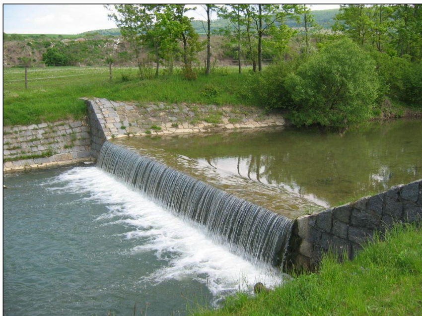
Obrázek 77 Původní stupeň před vybudováním balvanitého skluzu, 2004 (zdroj: M. Foltýn, Povodí Moravy, s.p.)
