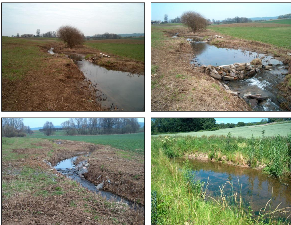
Obrázek 82 Původní stav koryta a opevnění kvádrovými tvárniciemi (2005)
