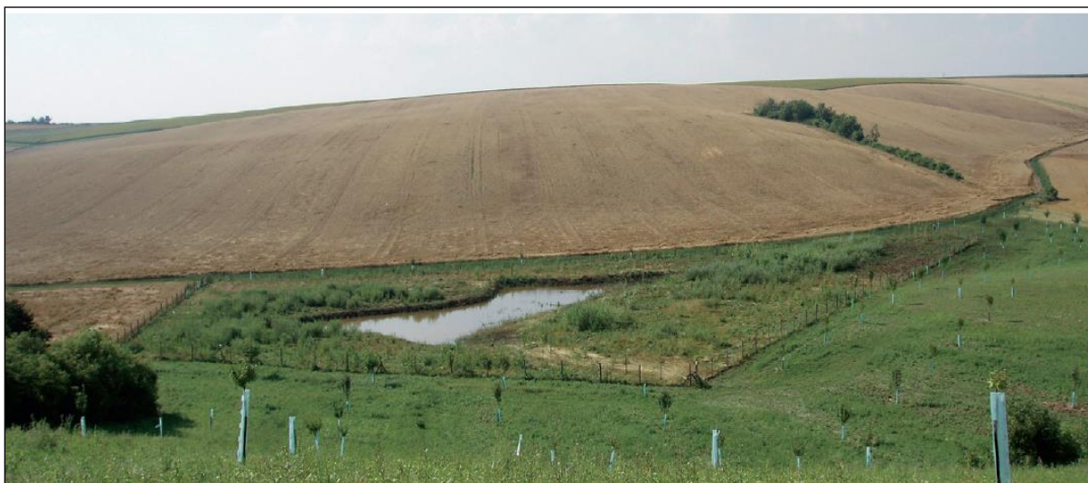
Obrázek 73 Lokalita těsně po realizaci opatření (Zdroj: Ing. Dr. Marada)
