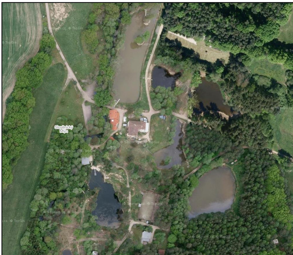
Obrázek 7 Stav po realizaci opatření v r. 2015 – soustava malých vodních nádrží, Miletínský potok, Dolní Slověnice (zdroj: mapy.cz)
