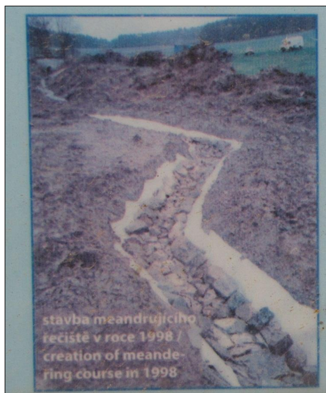
Obrázek 101 Stavba meandrujícího koryta v roce 1998
