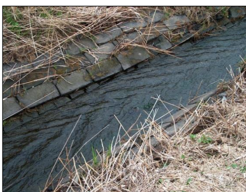
Obrázek 82 Původní stav koryta a opevnění kvádrovými tvárniciemi (2005)
