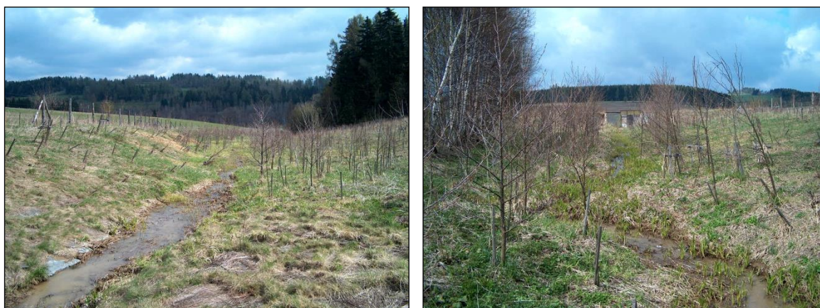
Obrázek 88 Koryto odtrubněného toku a stav výsadem v oplocence v roce 2005. Vpravo je na snímku patrná i hráz a stavidlový objekt dolní retenční nádrže.
