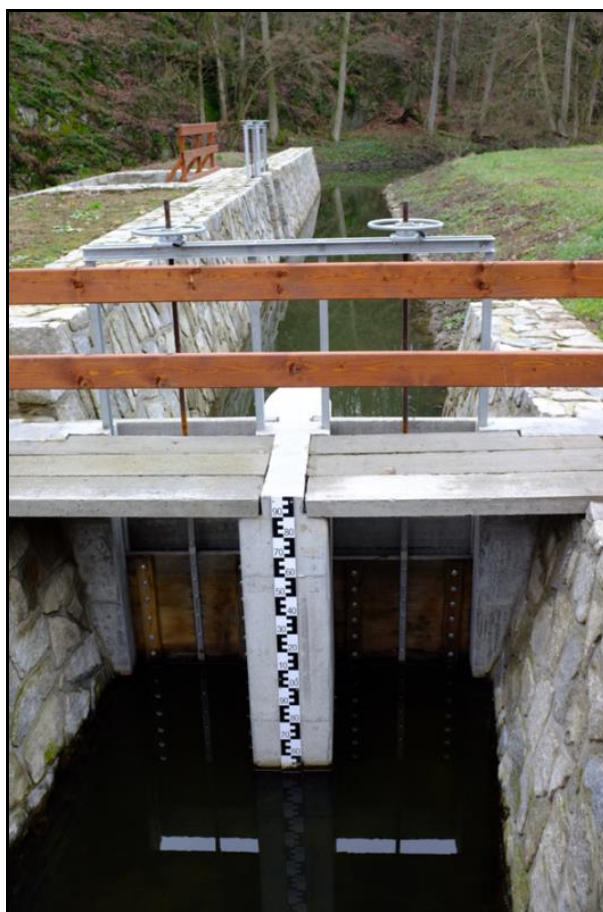
Obrázek 22 Opravený nátok do mlýnského náhonu u Venclova mlýna na Jevišovce
