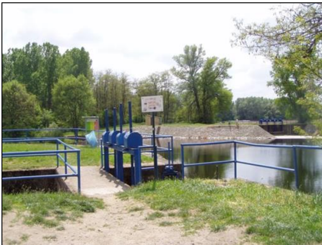
Obrázek 16 Nově upravený jez a nátok do závlahového kanálu, Krhovice
