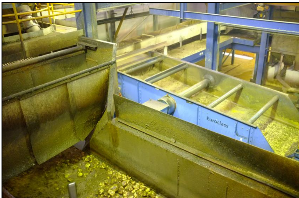
Obrázek 26 Modernizovaný provoz cukrovaru v Hrušovanech nad Jevišovkou
