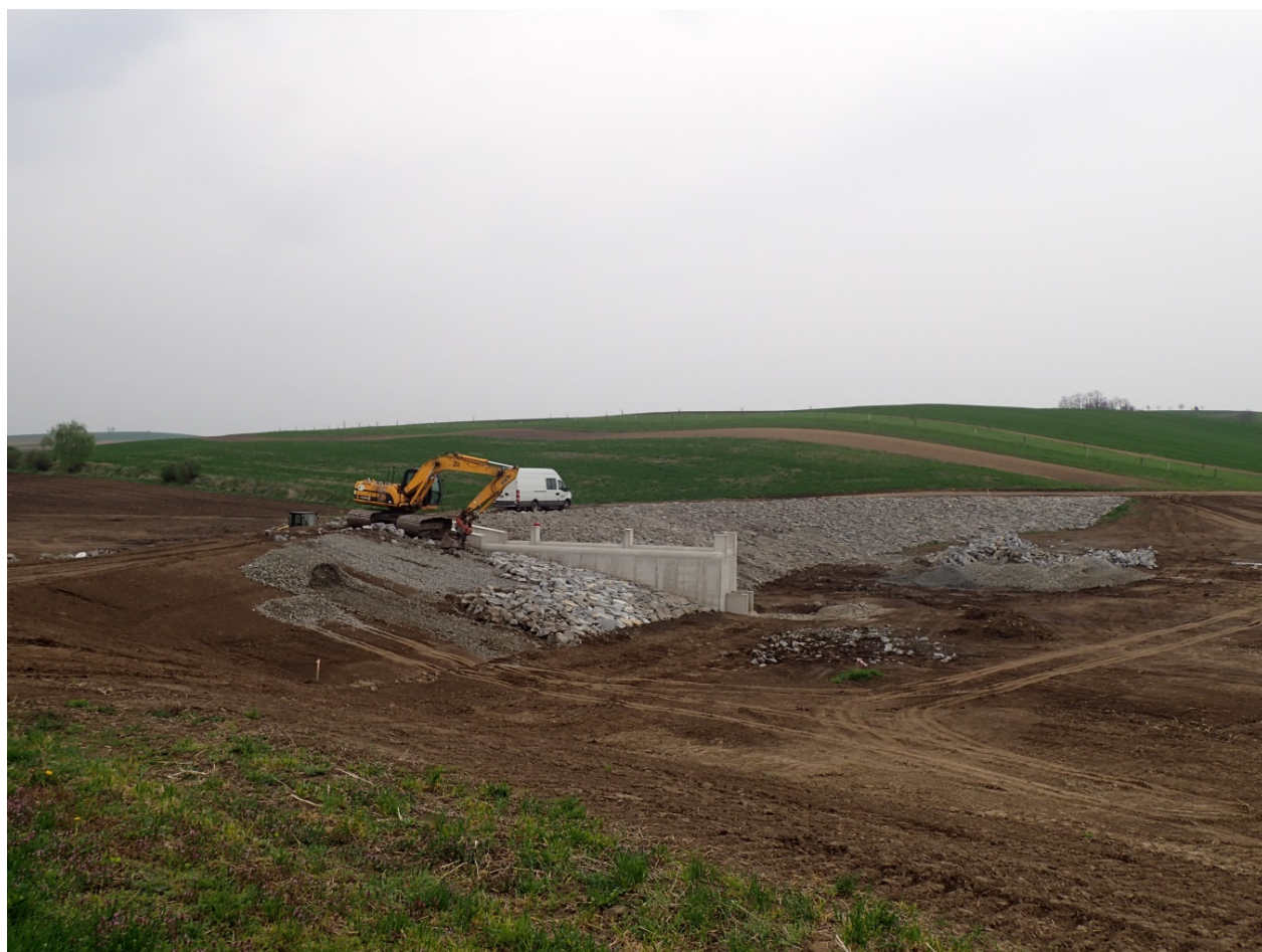
Obrázek 6: Průběh stavby ochranné retenční nádrže v dubnu 2018
