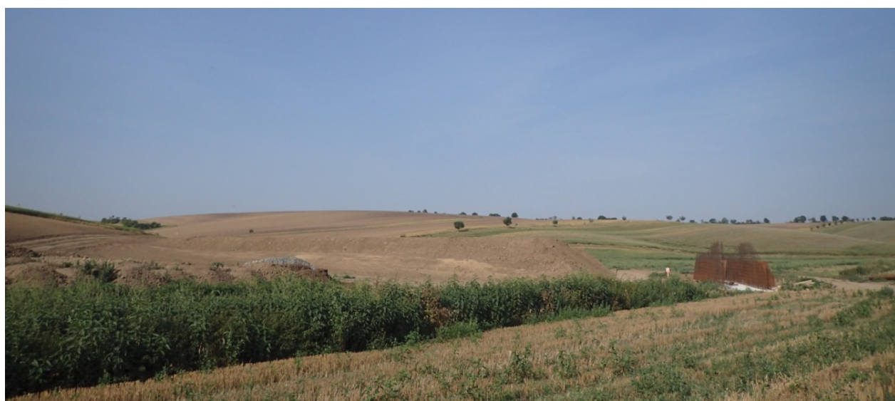
Obrázek 5: Ochranná retenční nádrž během realizace, stav v srpnu 2017
