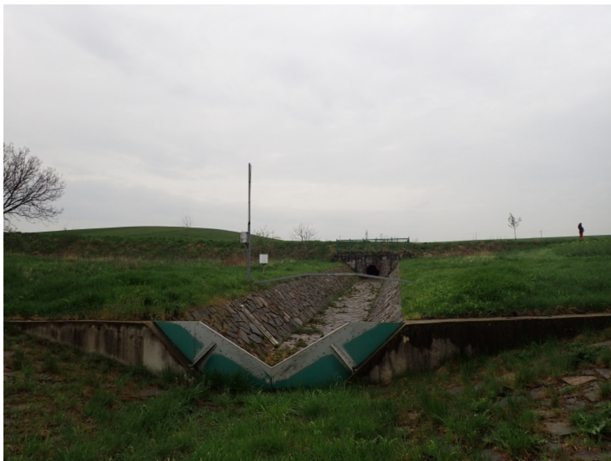
Obrázek 7: Měrný přeliv se srážkoměrem pod silničním propustkem
