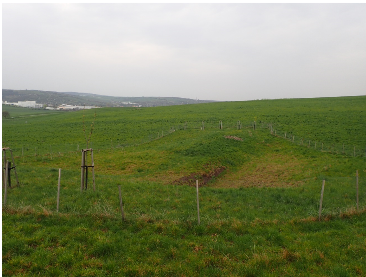
Obrázek 8: Zatravněná přehrážka ve stabilizované (zatravněné) DSO
