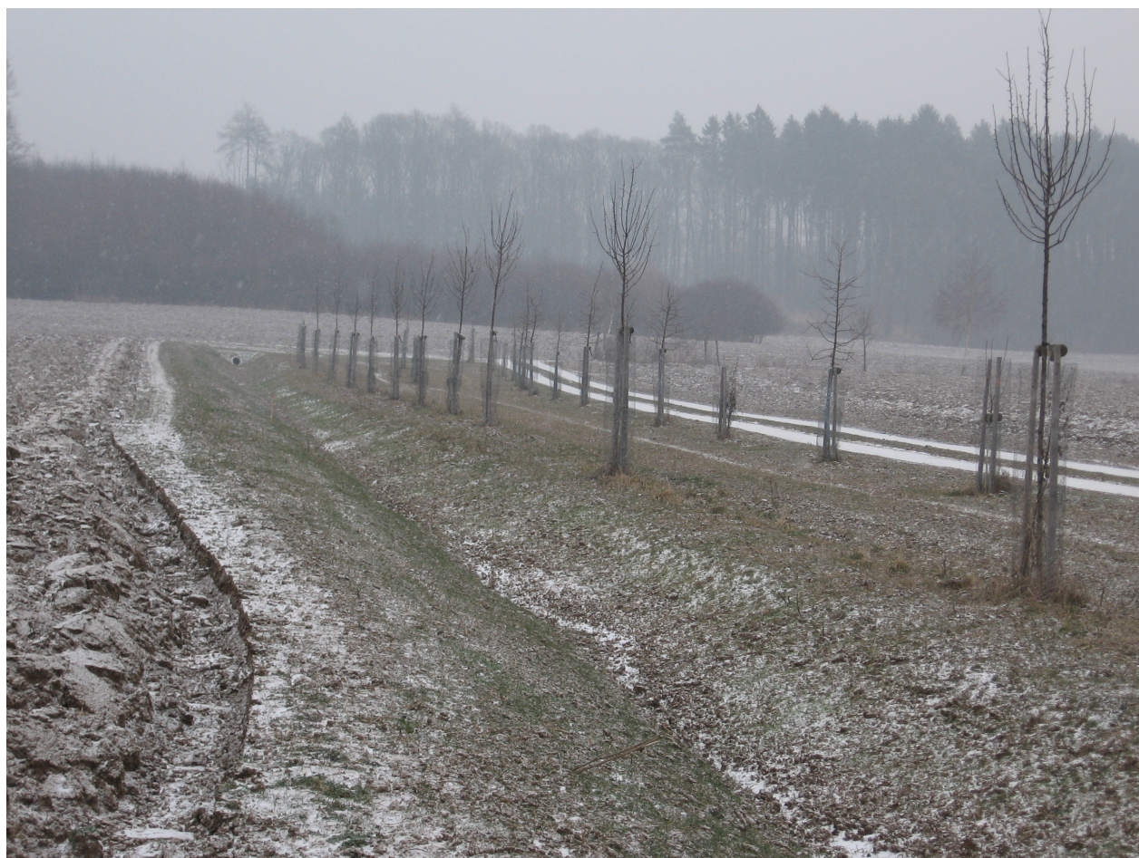
Obrázek 11: Zpevněná kolejová polní cesta s příkopem a ozeleněním po výstavbě
