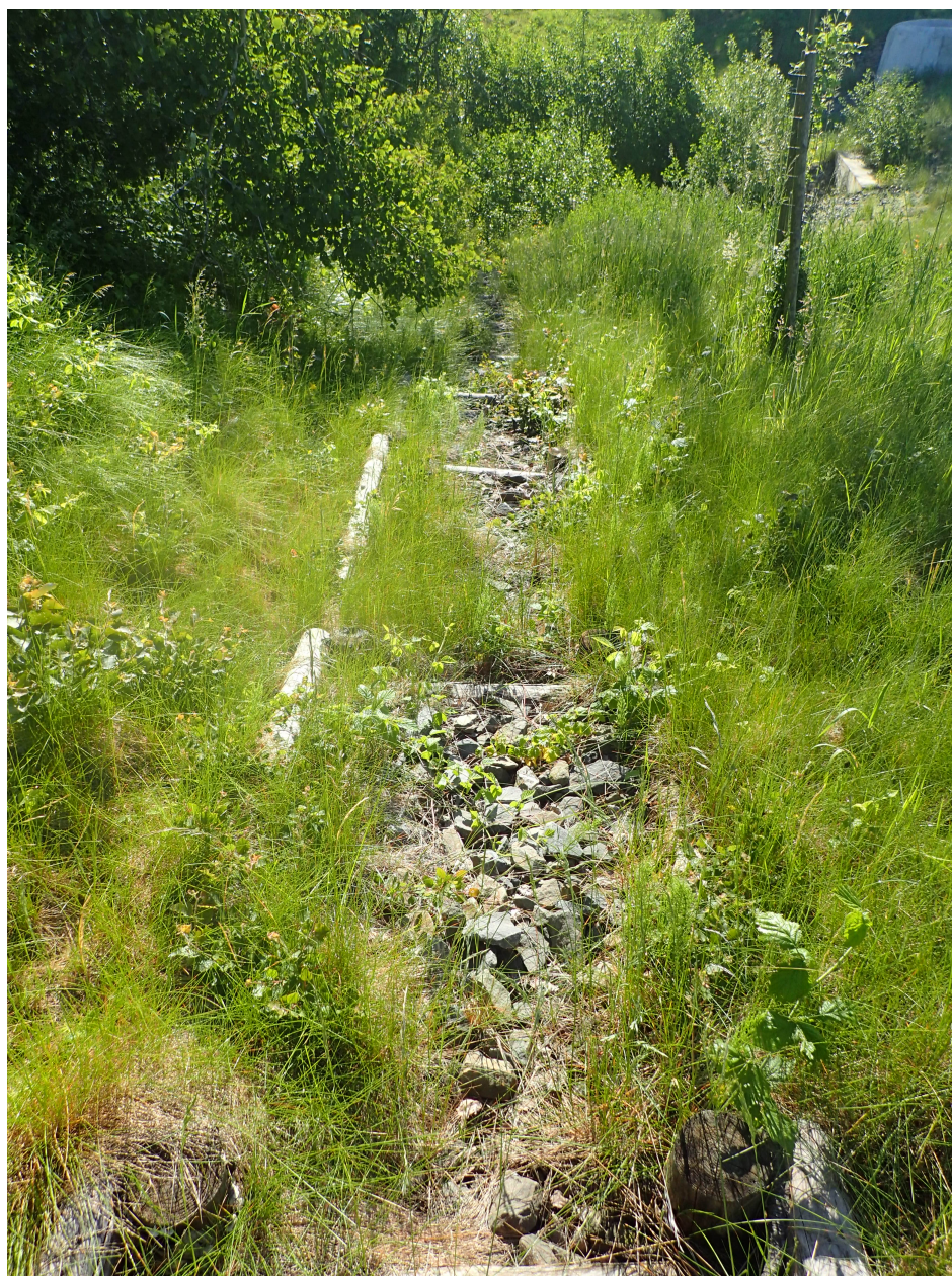
Obrázek 10: Svodný zpevněný příkop v roce 2017
