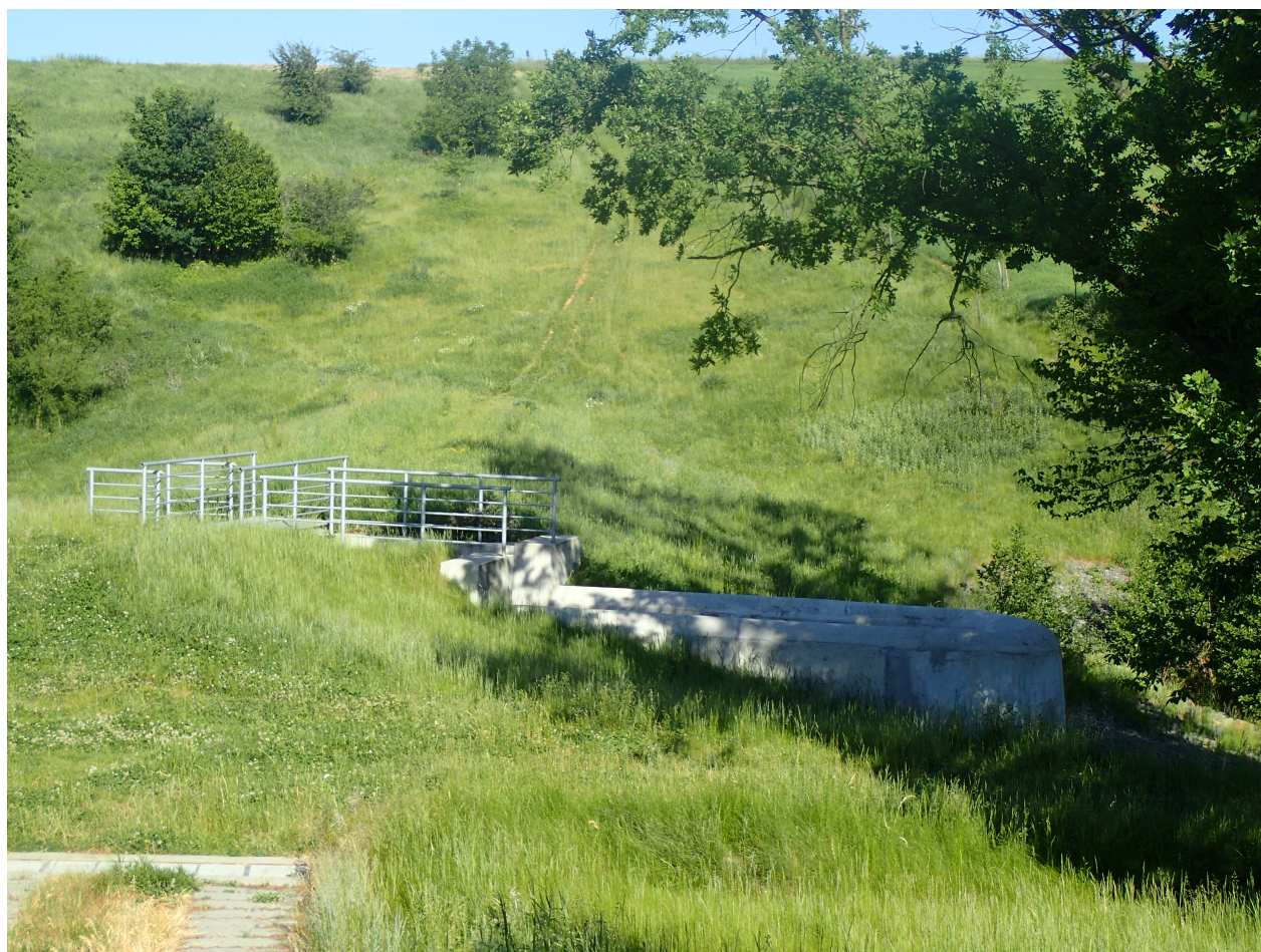
Obrázek 5: Suchá retenční nádrž - bezpečnostní přeliv
