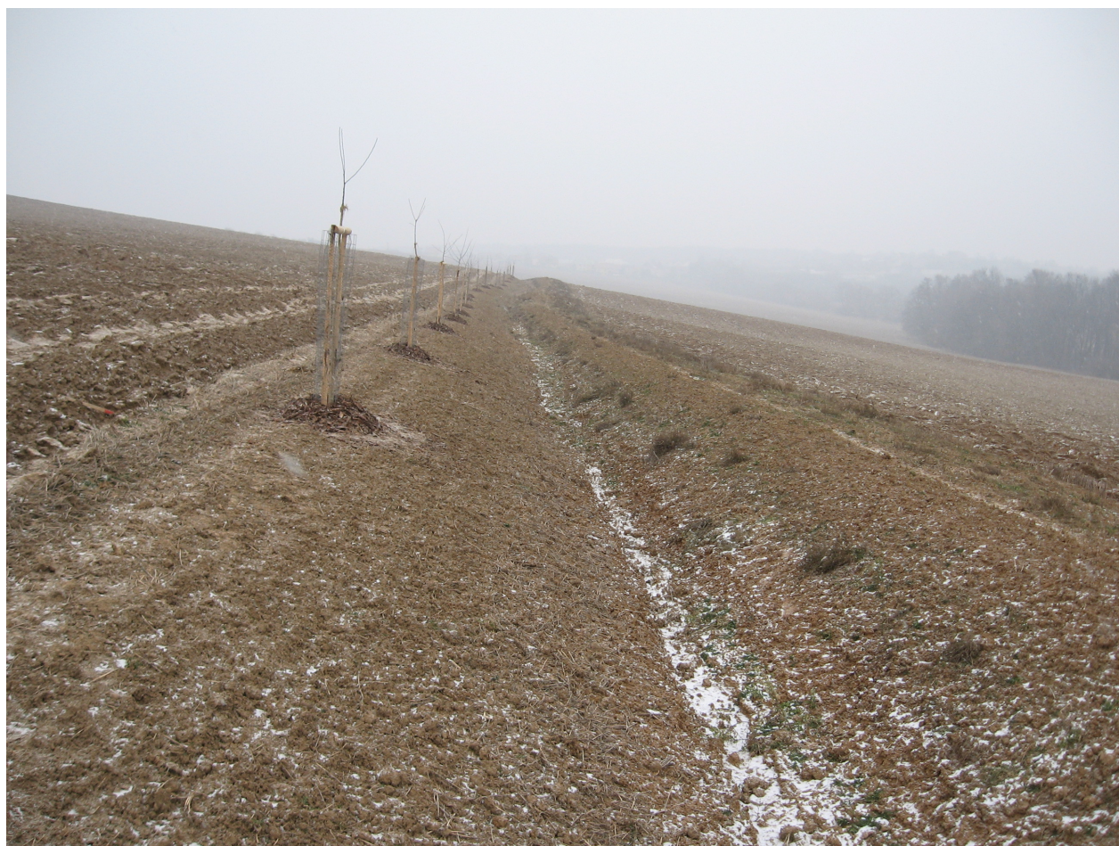
Obrázek 7: Záchytný průleh s doprovodnou zelení po výstavbě
