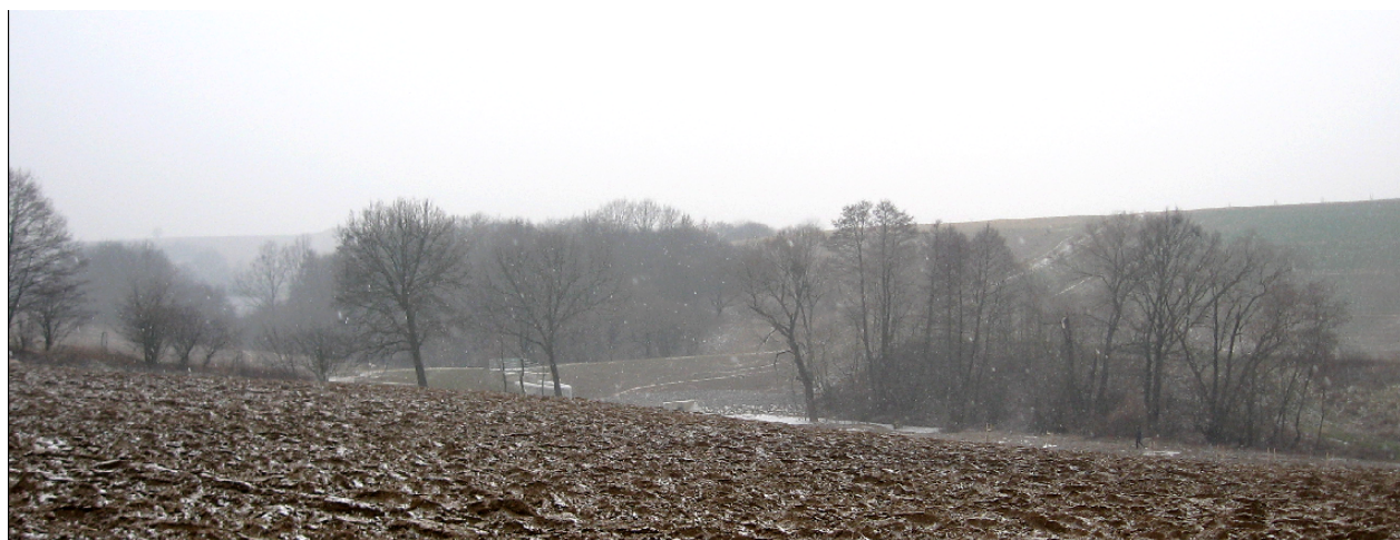
Obrázek 4: Suchá retenční nádrž - pohled na hráz po realizaci
