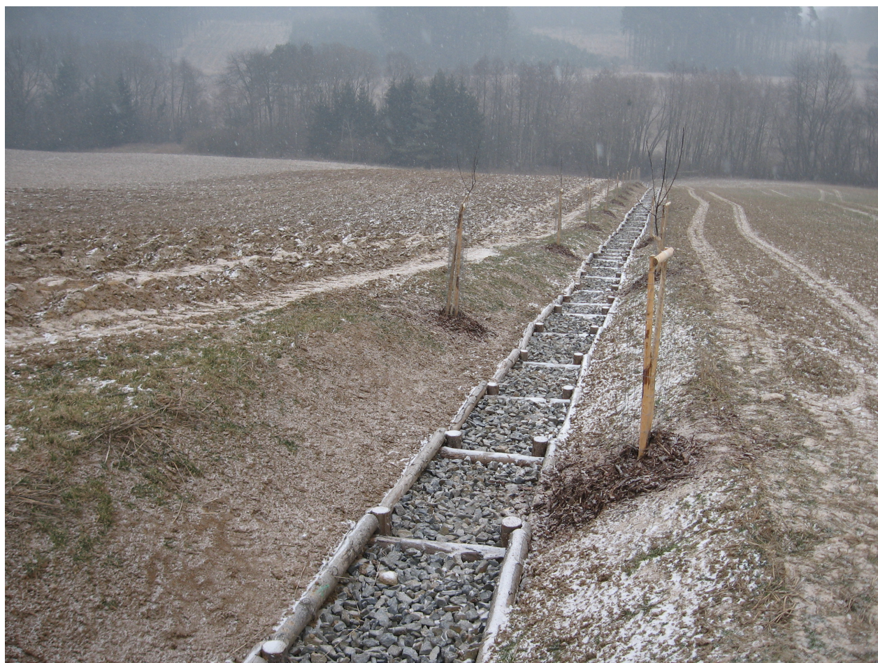
Obrázek 9: Svodný zpevněný příkop s doprovodnou zelení po výstavbě
